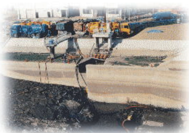
河川浚渫(しゅんせつ)工事状況
