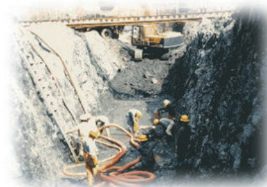
ダム岩盤清掃工事状況
